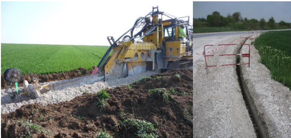
Figure 3 : Exemple de tranchée réalisée (Source : TotalEnergies)
